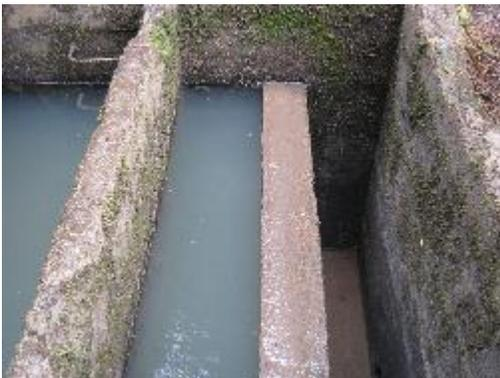
Fotografía 17. Zona de Salida del Desarenador 1
