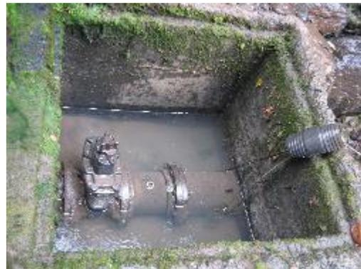
Fotografía 18. Válvula de Corte del Desarenador
