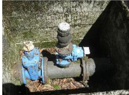
Fotografía 22. Válvula Cortina y de Aire 2” Desarenador 2
