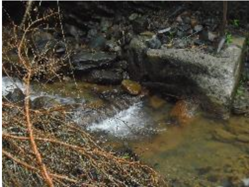
Fotografía 1. Vista Frontal de Bocatoma
