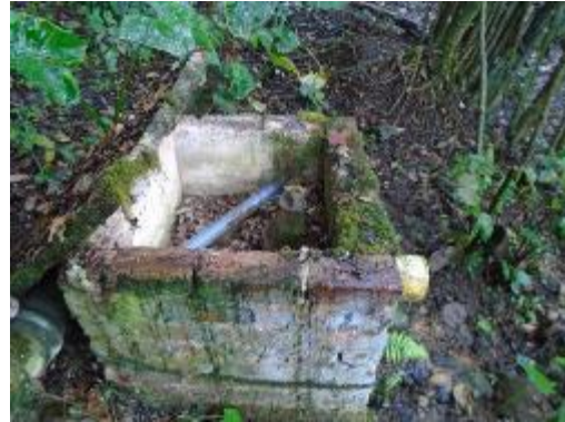
Fotografía 18. Vista Lateral Válvula de Purga
