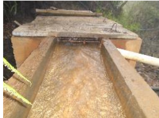
Fotografía 4. Vista Superior de Bocatoma
