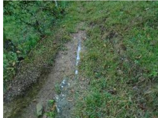
Fotografía 14. Tramo de la Conducción
