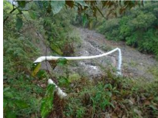
Fotografía 10. Lavado del Desarenador y excesos
