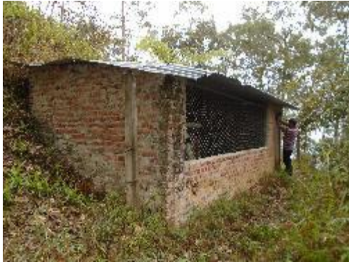
Fotografía 31. Estación de Filtrado
