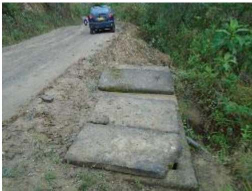
Fotografía 23. Vista Superior Cámara de Quiebre
