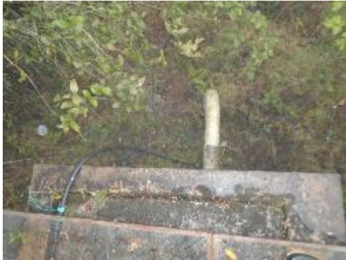
Fotografía 9. Salida del desarenador
