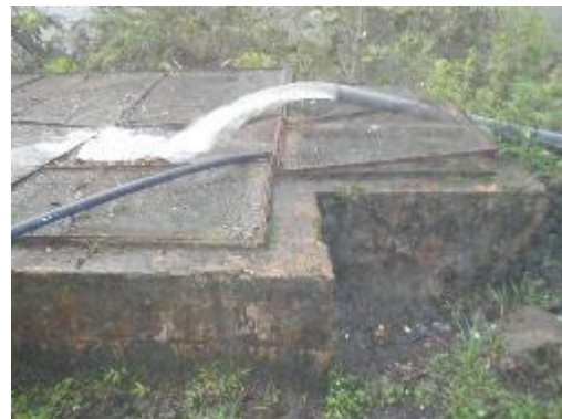
Fotografía 8. Vista Superior Desarenador- ingreso
