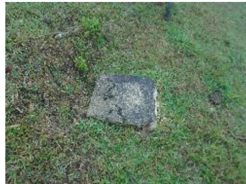
Fotografía 16. Caja Válvula de Aire
