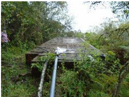
Fotografía 7. Vista Superior Desarenador
