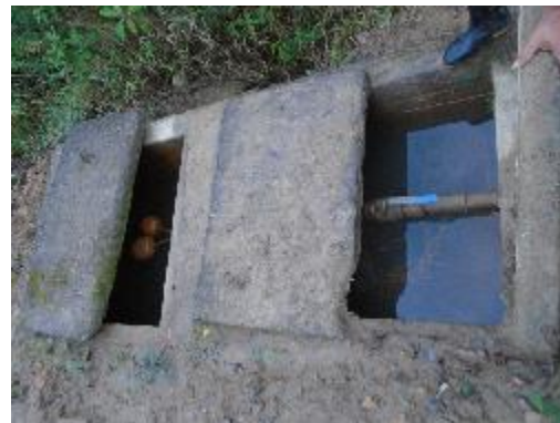
Fotografía 24. Vista Lateral Cámara de Quiebre
