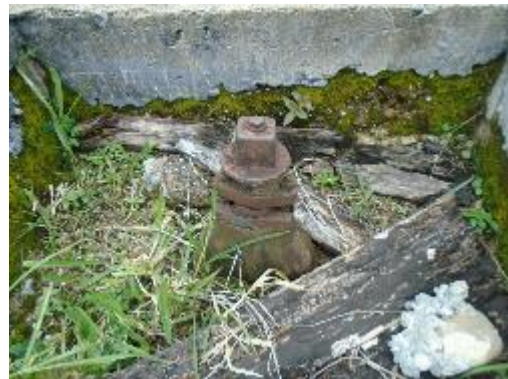
Fotografía 20. Vista Lateral Válvula de Purga
