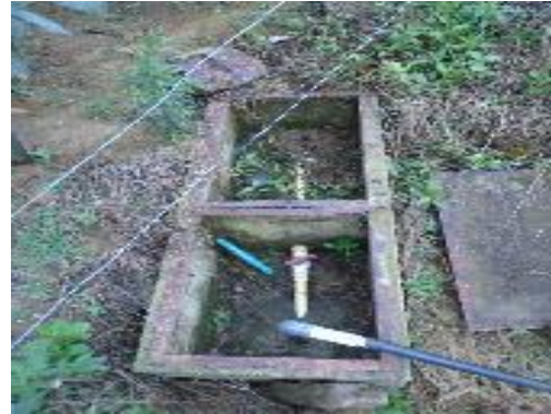
Fotografía 36. Acometida protegida
