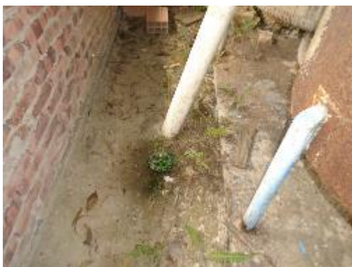
Fotografía 29. Estación de Filtrado
