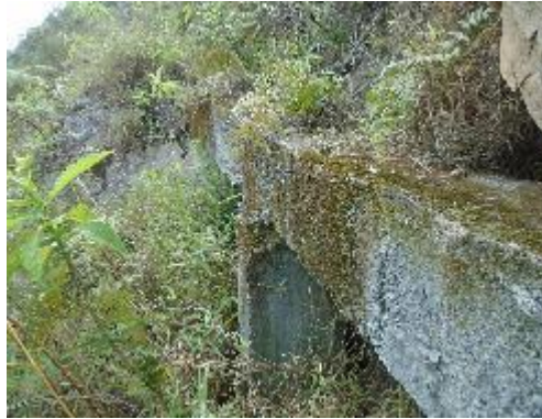
Fotografía 62. Encofrado No 4 para tubería de PVC
