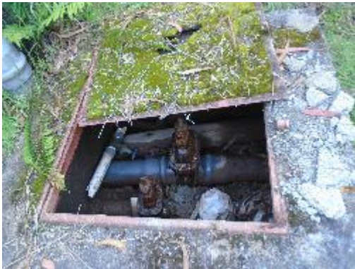
Fotografía 52. Derivaciones a los Ramales
