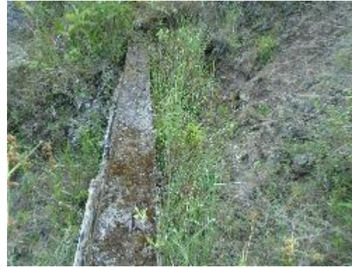
Fotografía 63. Encofrado No 4 para tubería de PVC
