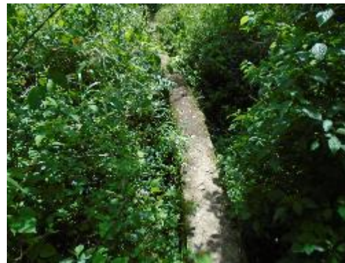
Fotografía 59. Encofrado No 1 para tubería de PVC
