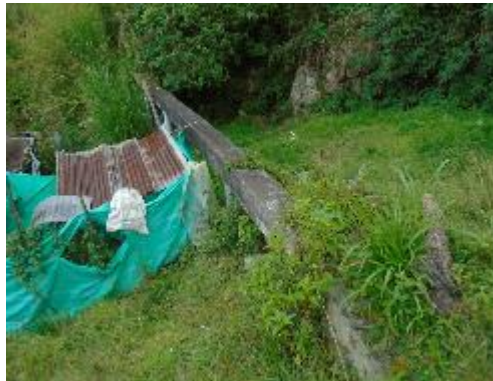
Fotografía 64. Encofrado No 7 para tubería de PVC
