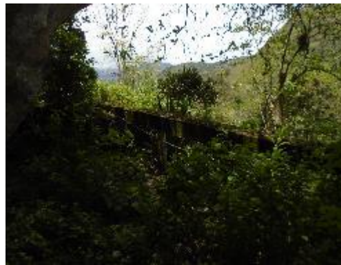
Fotografía 60. Encofrado No 2 para tubería de PVC
