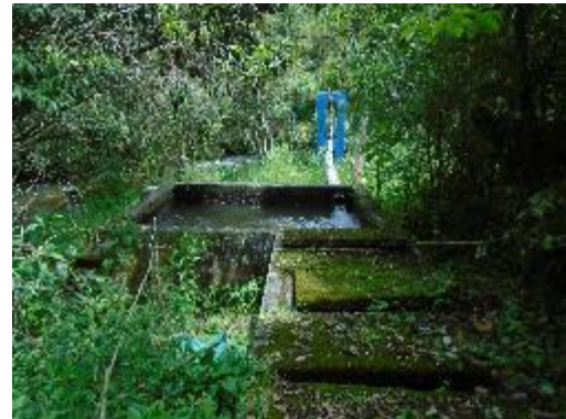
Fotografía 12. Desarenador
