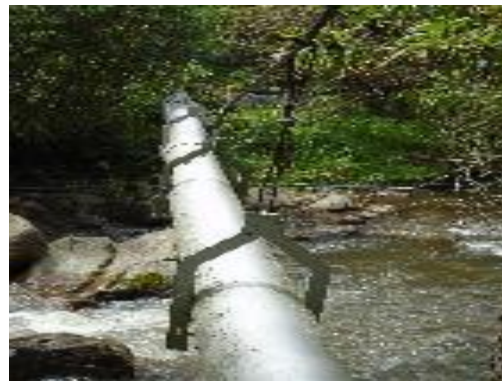
Fotografía 10. Paso elevado de la Aducción. Viaducto de Tubería
