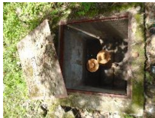
Fotografía 35. Válvula de Aire
