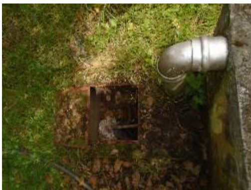
Fotografía 13. Cámara Registro Lavado Tanque Recolección
