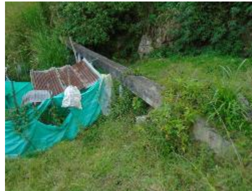
Fotografía 65. Encofrado No 7 para tubería de PVC
