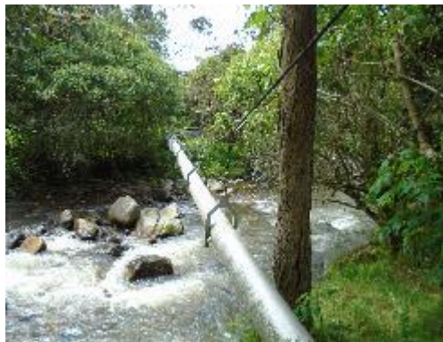
Fotografía 9. Paso elevado de la Aducción. Viaducto de Tubería
