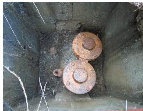
Fotografía 43. Válvula de Aire
