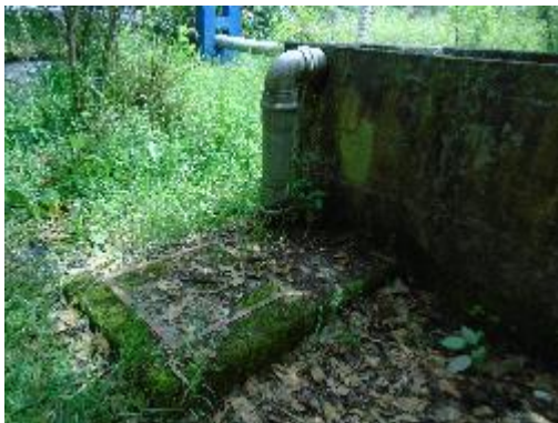
Fotografía 13. Cámara Registro Lavado Tanque Recolección
