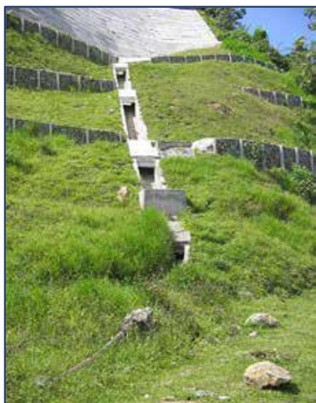
Canales – conducción de aguas lluvias
