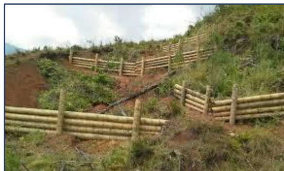
Trinchos en guadua – para retención de masas
