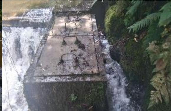
**Fotografía 6.** Vista Tanque de Bocatoma
