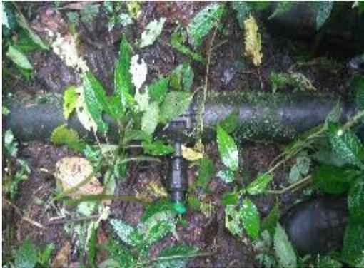
**Fotografía 34.** Válvula de Aire, descubierta y no funciona
