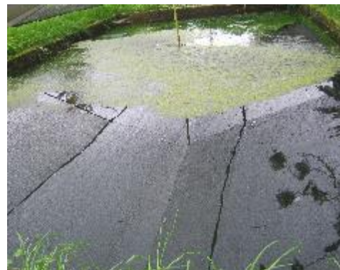
Fotografía 10. Tanque de Almacenamiento y distribución
