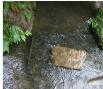
Fotografía 4. Vista Superior de la Captación
