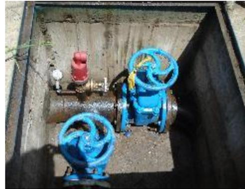
Fotografía 44. Válvula de Corte No 3 y 4, Válvula de Aire 2
