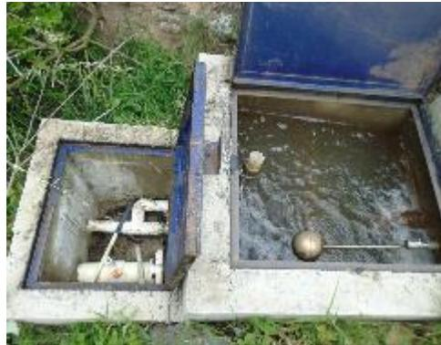
**Fotografía 59.** Cámara perdida de Presión y válvula de Lavado
