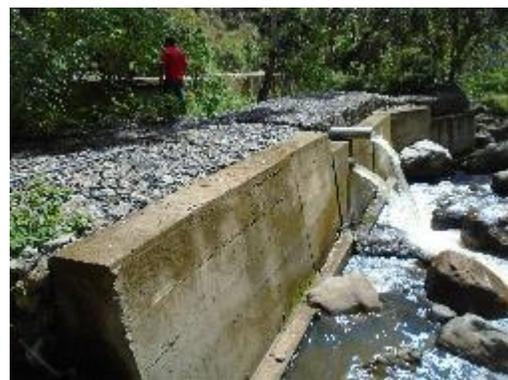
Fotografía 16. Muro de Protección del Desarenador
