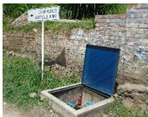
**Fotografía 42.** Válvula de Corte No 3 y 4,
