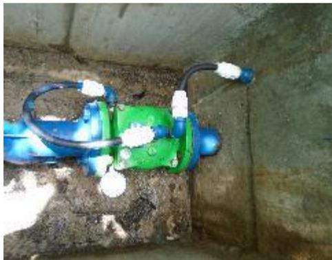
Fotografía 67. Válvula de Control de Nivel de C.Q. No 3
