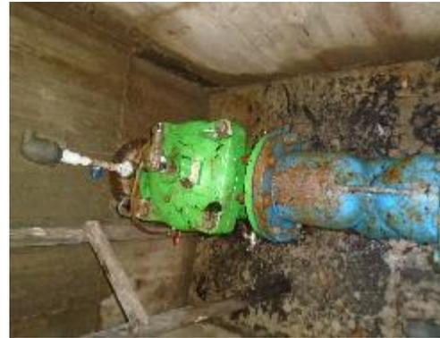
**Fotografía 54.** Válvula Reductora de Presión
