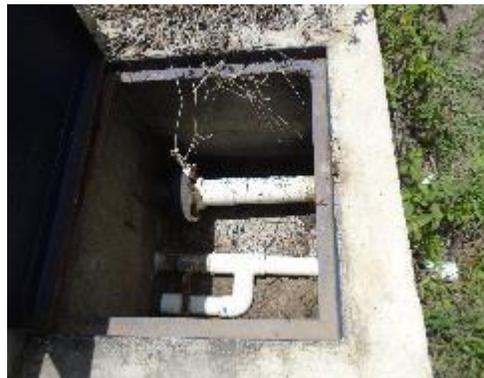
**Fotografía 79.** Válvula Lavado y salida excesos C.Q. No 5
