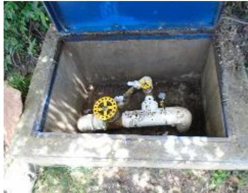
Fotografía 49. Válvula de Corte 5 y 6 para Ramal
