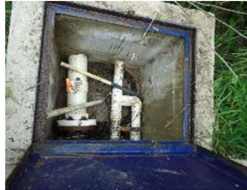
**Fotografía 60.** Válvula Lavado y salida excesos
