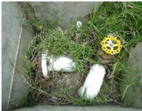
**Fotografía 57.** Entrada C.Q. No 2 y Válvula Corte No 5 Ramal
