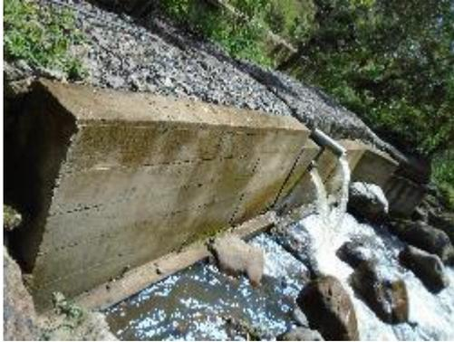
Fotografía 17. Muro de Protección del Desarenador
