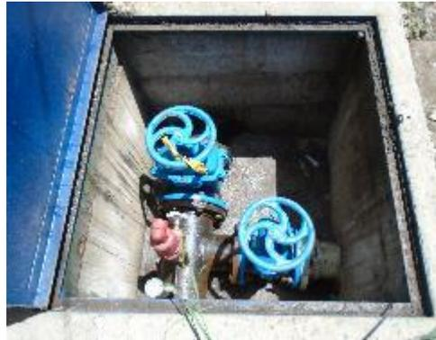
Fotografía 43. Válvula de Corte No 3 y 4, Válvula de Aire 2
