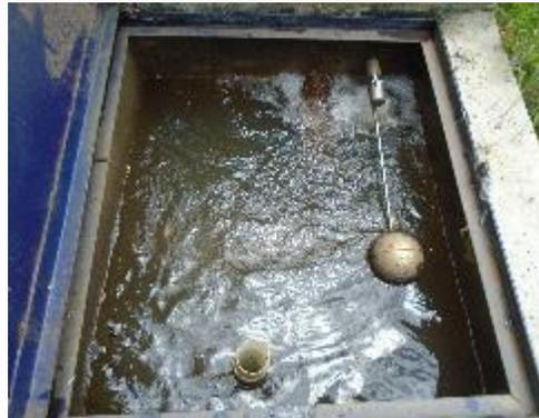
**Fotografía 61.** Cámara perdida de Presión C.Q. No 2
