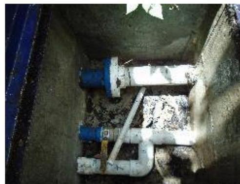
Fotografía 70. Válvula Lavado y salida excesos
