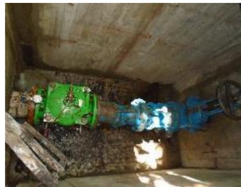
Fotografía 52. Valvulería de la Cámara Reductora
