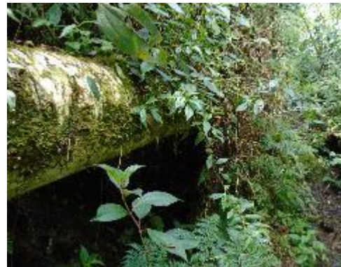
Fotografía 31. Tubería a Nivel de terreno
