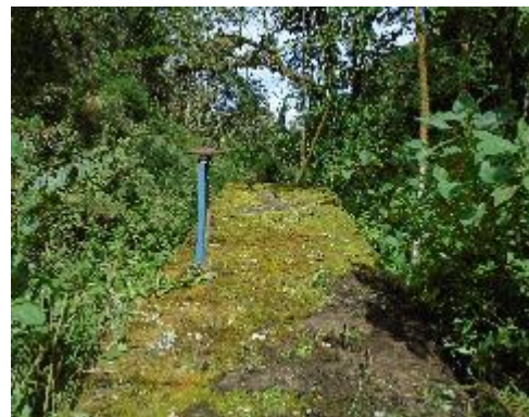
Fotografía 16. Vista superior desarenador
