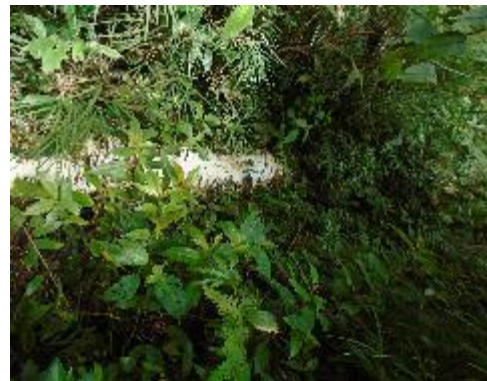
Fotografía 33. Tubería a Nivel de terreno
