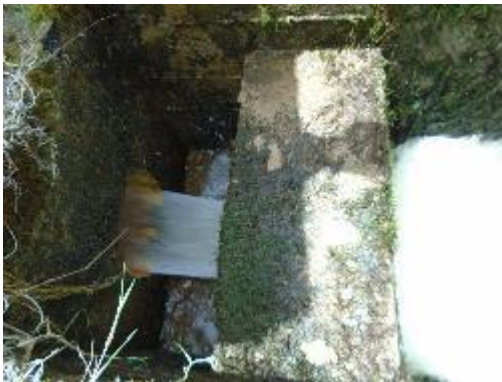
Fotografía 36. Cámara de perdida de Presión C.Q.1
