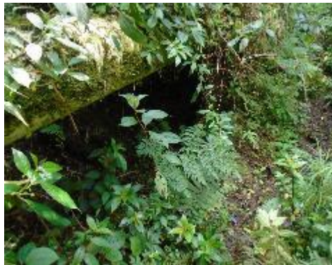
Fotografía 30. Tubería a Nivel de terreno
