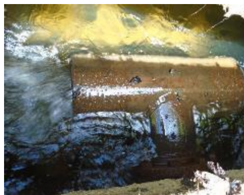
Fotografía 12. Zona de Entrada
