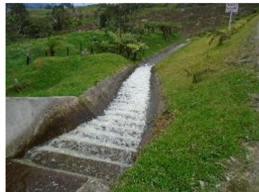
Fotografía 57. Canal de excesos del reservorio
