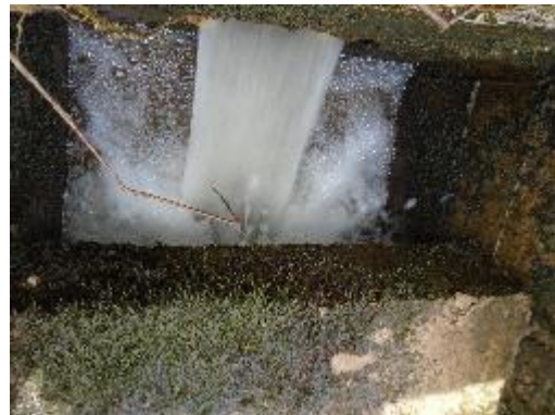
Fotografía 37. Cámara de perdida de Presión C.Q.1
