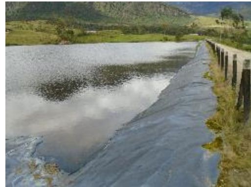
Fotografía 53. Reservorio Recubierto
