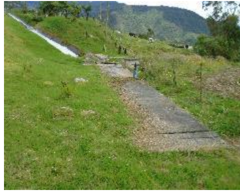
Fotografía 18. Vista Frontal desarenador No 2
