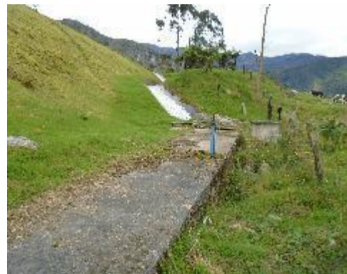
Fotografía 21. Vista Superior desarenador 2
