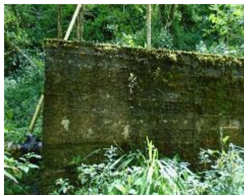
Fotografía 17. Vista lateral desarenador
