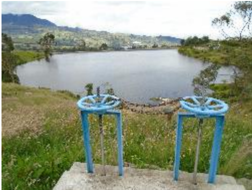
Fotografía 40. Válvulas de Control CQ2
