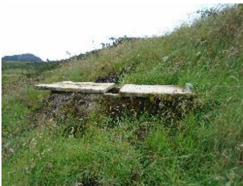
Fotografía 36. Cámara de perdida de Presión C.Q.1
