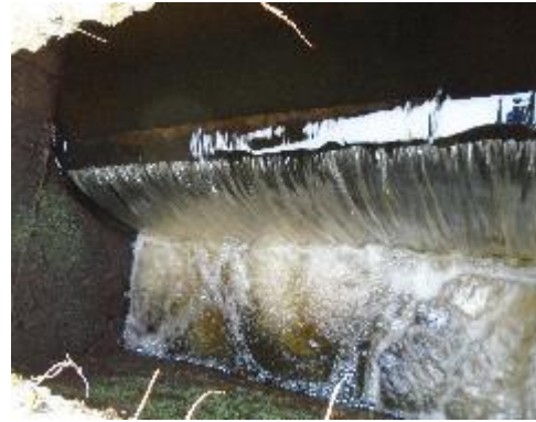
Fotografía 19. Zona de Salida Desarenador 2
