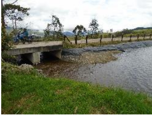
Fotografía 58. Canal de excesos del reservorio
