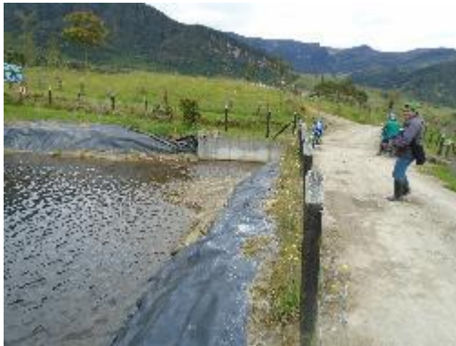
Fotografía 54. Reservorio Recubierto
