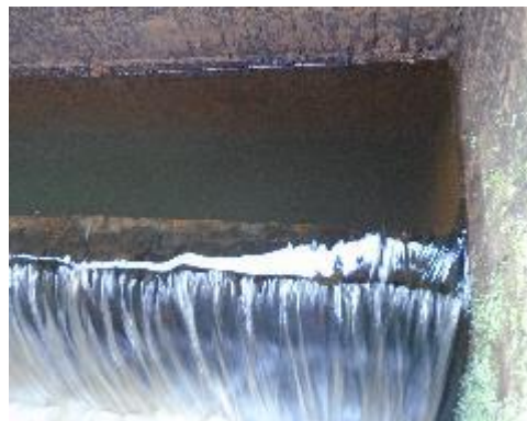
Fotografía 20. Zona de Salida Desarenador 2
