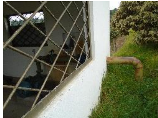
Fotografía 2. Inicio de conducción Principal
