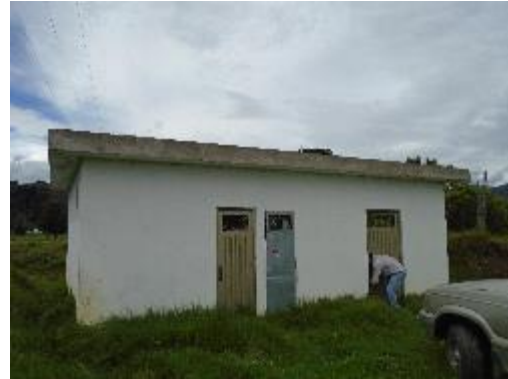
Fotografía 6. Caseta de Bombeo
