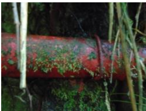
Fotografía 25 Primer Paso Elevado (Anclajes)
