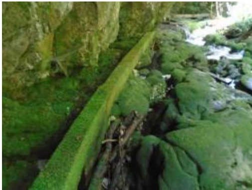
Fotografía 9 Tubería de Aducción Encofrada
