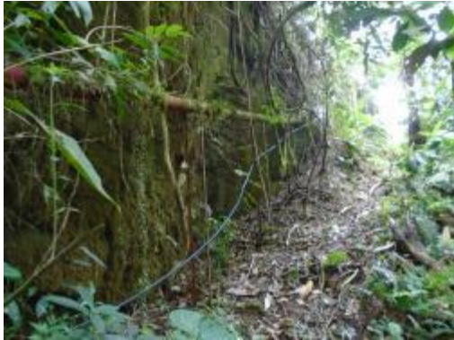
Fotografía 27 Primer Paso Elevado (Anclajes)
