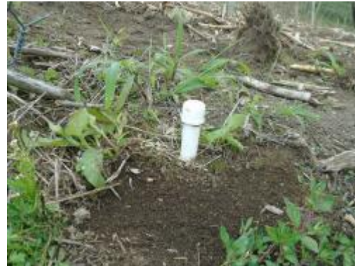
Fotografía 40 Válvula de Aire
