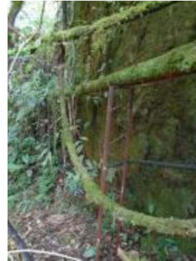
Fotografía 28 Primer Paso Elevado (Anclajes)
