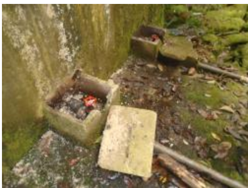
Fotografía 15 Valvulas de Lavado Desarenador
