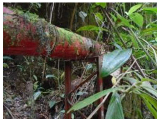
Fotografía 26 Primer Paso Elevado (Anclajes)
