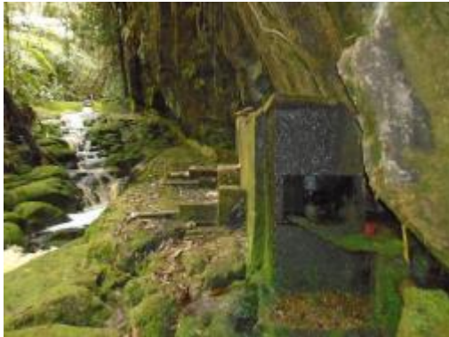
Fotografía 19 Válvula de salida Desarenador
