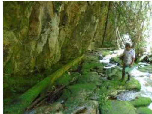
Fotografía 8 Tubería de Aducción Encofrada
