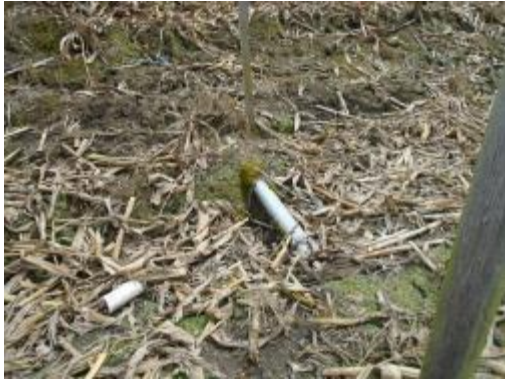
Fotografía 33 Red de conducción (Tramo destapado)
