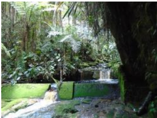
Fotografía 5. Vista Frontal de Bocatoma
