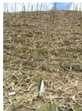
Fotografía 32 Red de conducción (Tramo destapado)
