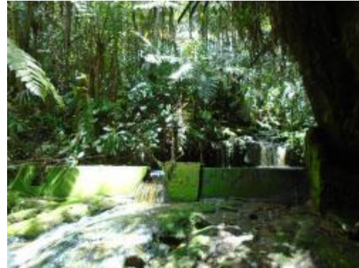
Fotografía 2. Vista Frontal de Bocatoma
