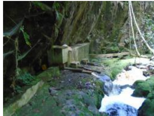
Fotografía 10 Tubería de Aducción Encofrada llegada al desarenador
