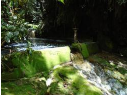
Fotografía 1. Vista Frontal de Bocatoma
