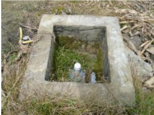
Fotografía 37 Válvula de Aire
