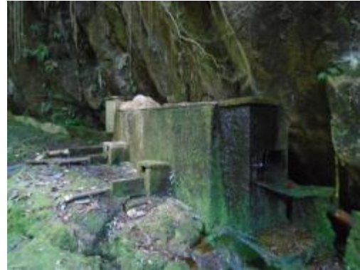
Fotografía 12 Desarenador
