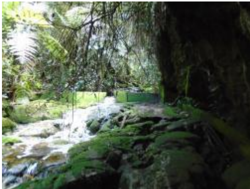
Fotografía 7 Tubería de Aducción Encofrada a la salida de bocatoma
