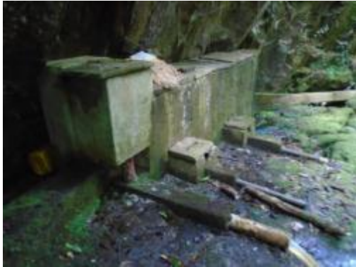
Fotografía 11 Desarenador
