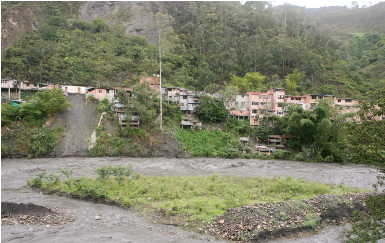
Puente Quetame, municipio de Quetame - Fuente: Archivo fotográfico - Secretaría de Prensa y Comunicaciones, Gobernación de Cundinamarca
