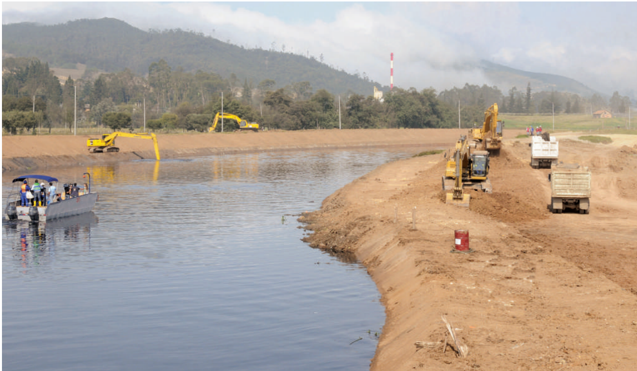
Adecuación hidráulica del Río Bogotá, Soacha - Fuente: Archivo fotográfico - Secretaría de Prensa y Comunicaciones, Gobernación de Cundinamarca
