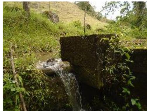
**Fotografía 10.** Vista Lateral Desarenador fuga en la tubería
