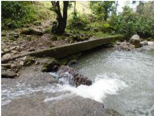
**Fotografía 3.** Inicio de la aducción, a la salida de la Bocatoma
