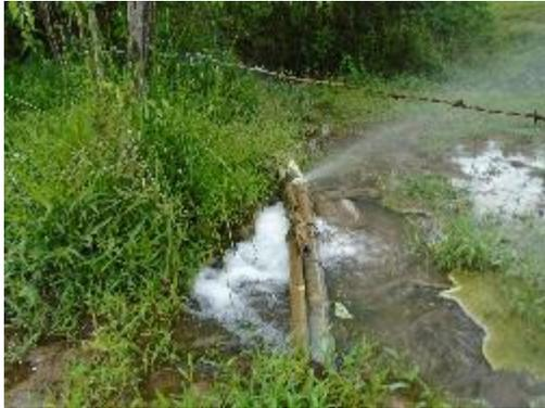
**Fotografía 24.** Conducción, tubería descubierta al paso de un riachuelo y con fuga
