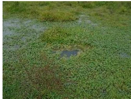
**Fotografía 23.** Conducción (no se trata de un cuerpo de agua natural, sino es el resultado de una fuga en un tiempo prolongado)
