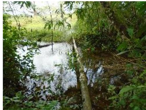
**Fotografía 27.** Conducción, tubería descubierta al paso de un riachuelo
